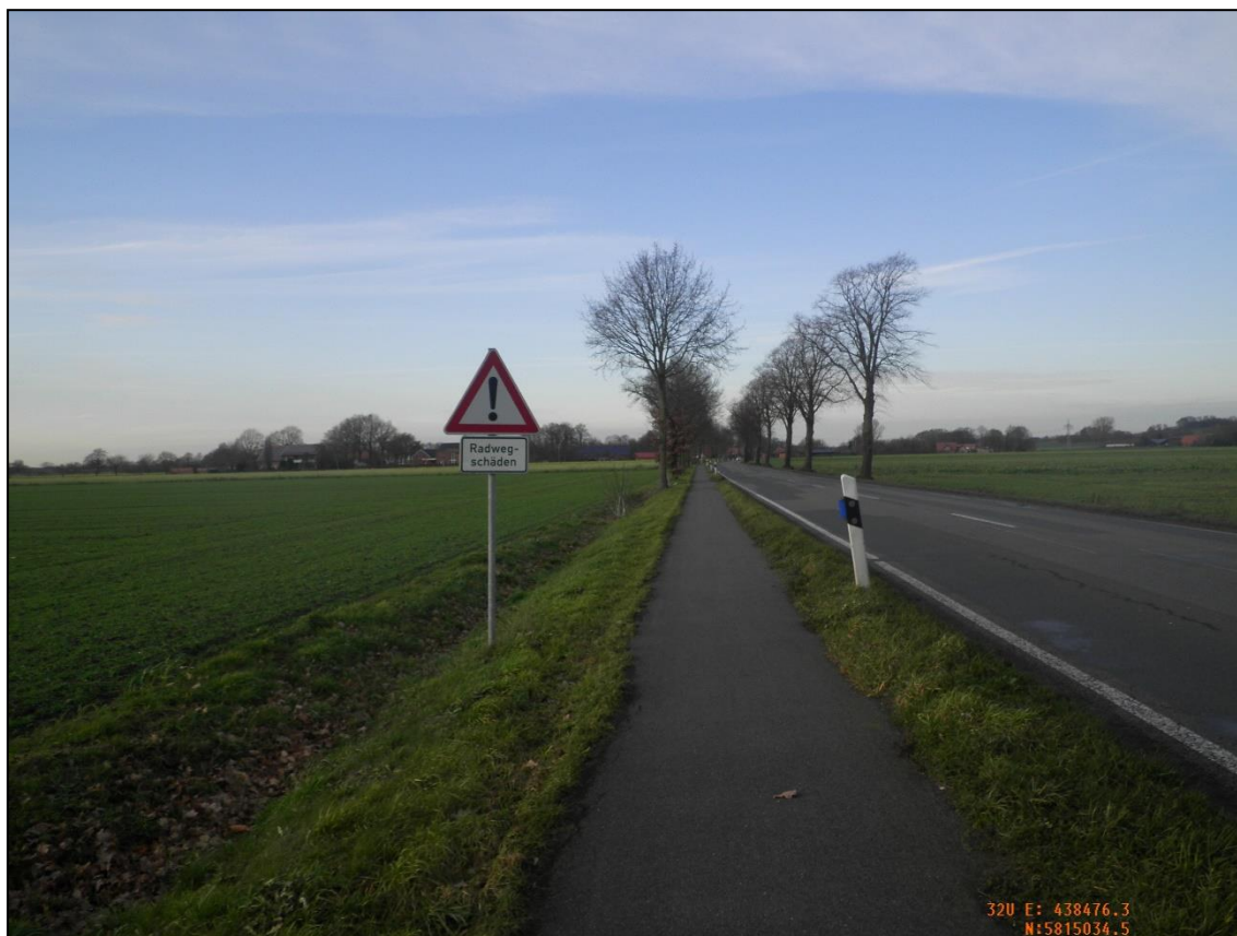
Abbildung 4: Blick entlang der Landesstraße L 76 in nördliche Richtung (Dezember 2019).
